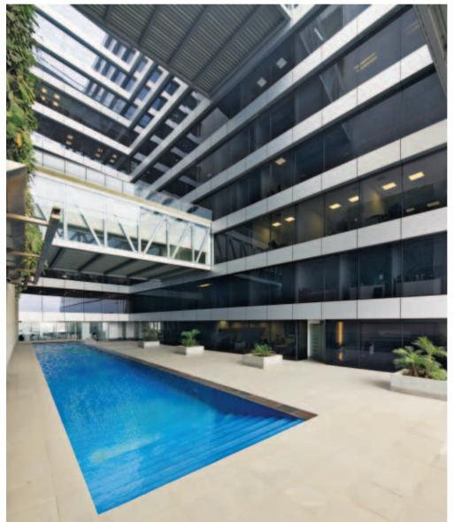
El muro lateral está diseñado como una suerte de mosaico que va entre los jardines verticales y planchas de fibrocemento como revestimientos. Esta composición resulta en un espacio abierto pero controlado que a, modo de patio interior, enriquece la vista de las oficinas.
