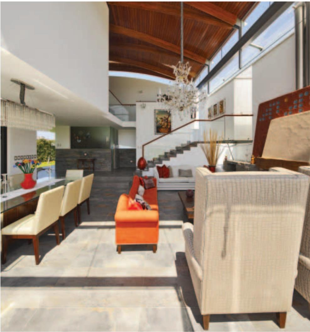
Este espacio lleva una cubierta curva sostenida por vigas laminadas, dispuestas en ángulo para que sus puntos de intersección caigan sobre los puntos de apoyo en los extremos de este espacio, y el sesgo en sus extremos acompañen a la volumetría. Se decidió utilizar la madera en estos elementos estructurales no sólo para darle calidez a la casa sino también como remembranza de la residencia que tienen sus propietarios en la ciudad.
