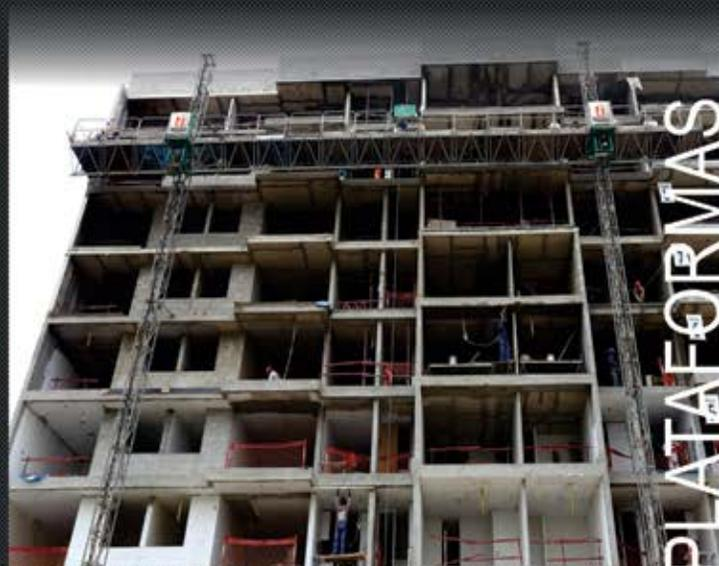
Plataformas para elevación de carga vertical mediante cremalleras operadas con sistema electromecánico para mejor precisión en el ascenso y descenso ofreciendo mejor producción, seguridad y comodidad en el trabajo del personal.
