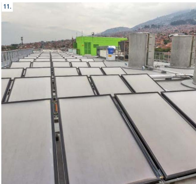
11. En la terraza se encuentra el cuarto de máquinas, 57 paneles solares, tanques de reserva de agua, unidades manejadoras de aire y otros equipos técnicos.
