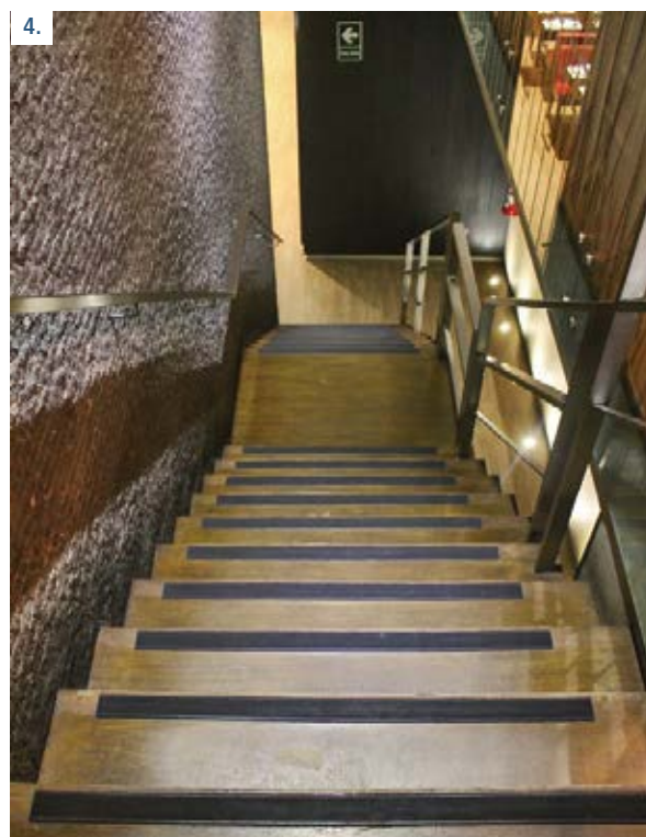
3 y 4. En el local de la Av. 28 de julio, los 40 metros lineales de cinta antideslizante fueron colocados en las rampas de la cocina, mientras que en el de la Av. Santa Cruz los más de 100 metros lineales se encuentran situados en las escaleras interiores y la exterior principal.
