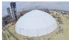
La construcción servirá para almacenar material molienda, insumo que sirve para la fabricación de cemento.
