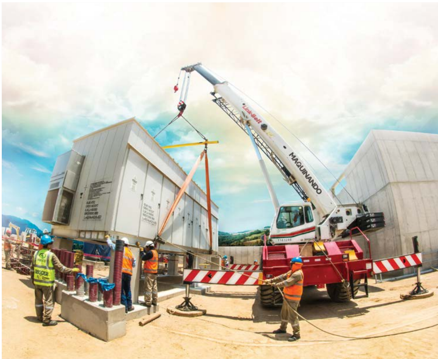
Obra "Planta de Reserva Fría Eten", Chiclayo - Lambayeque. Perú.
