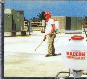
Aplicación del RADCON Formula #7<sup>®</sup> sobre una superficie de concreto
