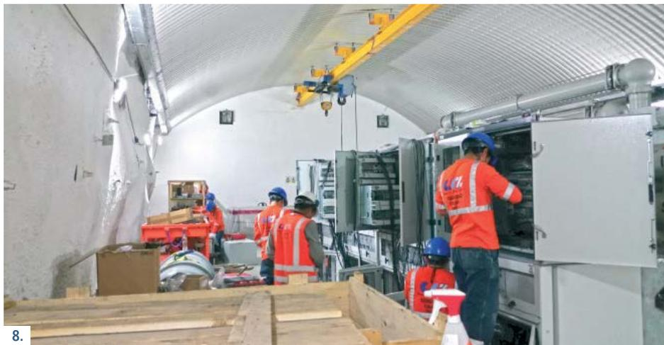
**8 y 9.** La casa de máquinas es una estructura donde se generará la electricidad, tiene 5 niveles (pisos) con 26 m de altura y 300 m<sup>2</sup> de área. La obra se encuentra ubicada a 1.1 km dentro del cerro "Mirahuay" y soporta 800 m de altura de suelo y roca.
