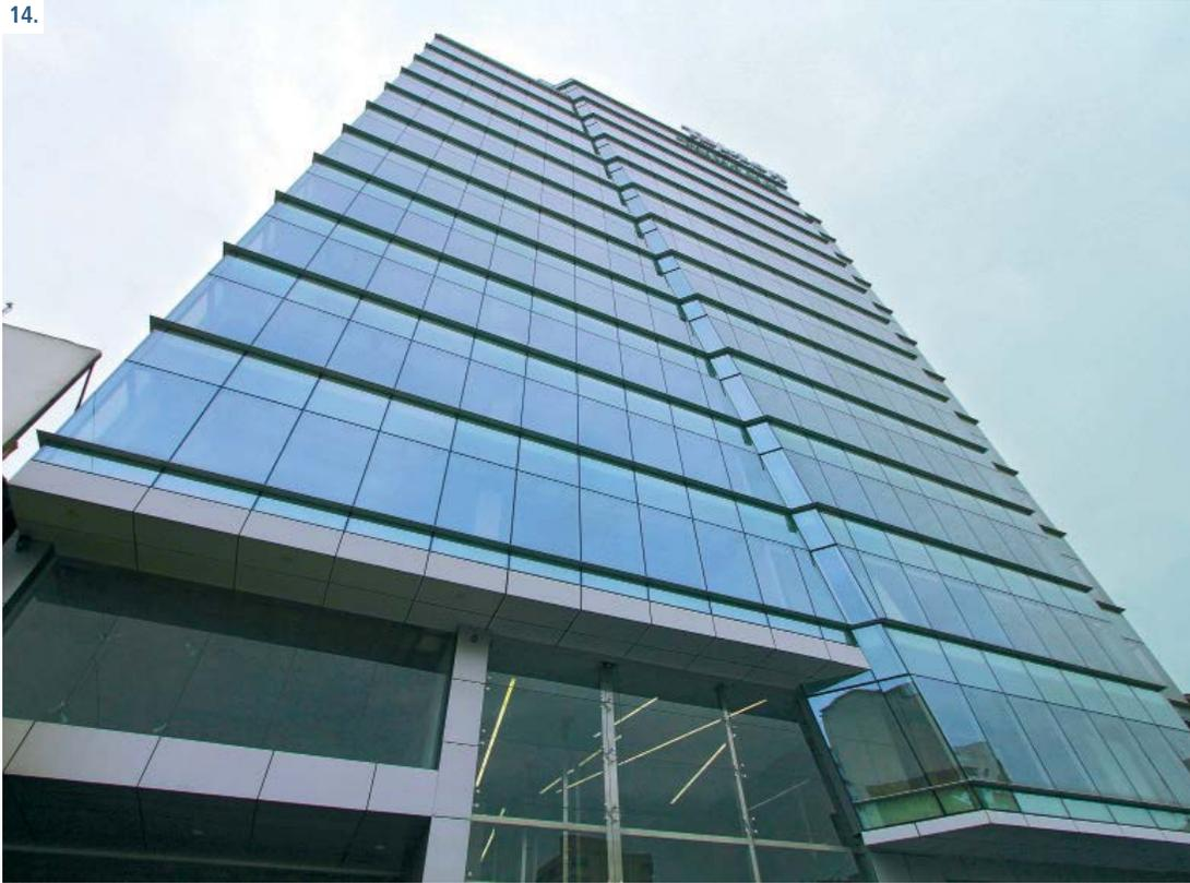
14. La fachada está cubierta de un muro cortina de cristal insulado el cual sirve de aislante térmico y acústico.
