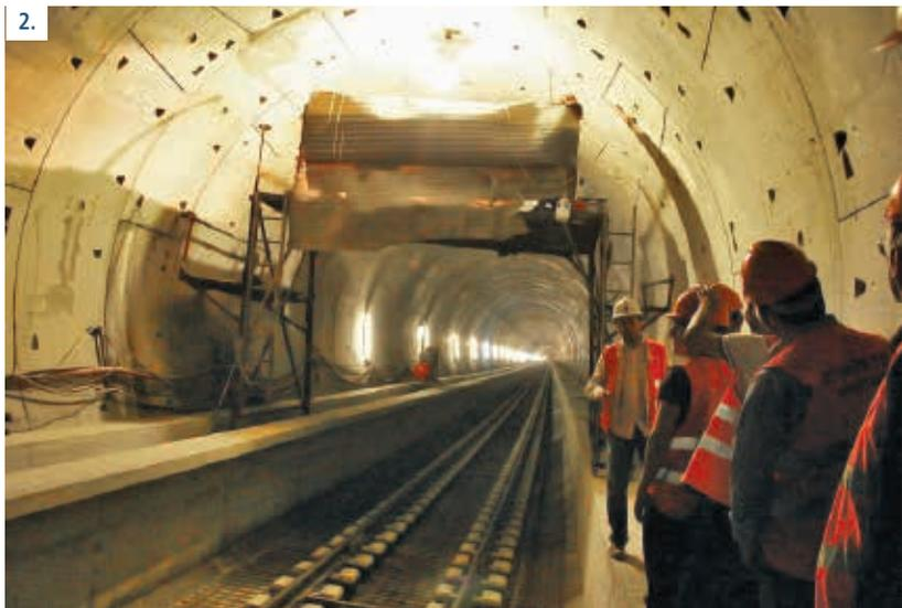
1 y 2. El túnel en tierra fue excavado con una TBM que completó 70% de la ruta, la que tuvo que pasar por áreas residenciales construidas de alta densidad a lo largo de todo el camino. Fue posible completar las excavaciones sin afectar ninguna edificación. La estación Sirkeci fue construida bajo un área residencial altamente densificada.
