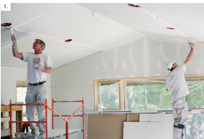
1. El instalador debe estar completamente capacitado y utilizar los elementos básicos, tales como perfiles, planchas de yeso, tornillos, cinta y macilla para las juntas.
