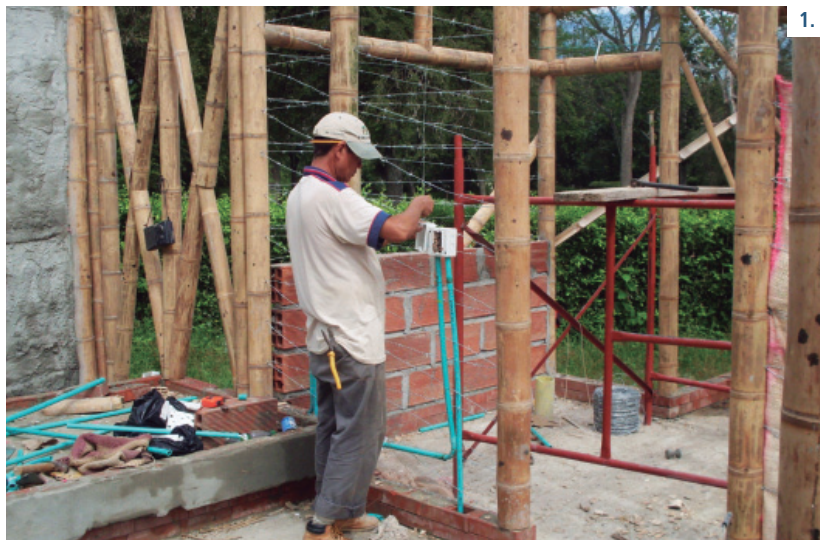
2. Antes de ejecutar los tabiques, se deben colgar del alambrado de púas las tuberías de instalaciones.
