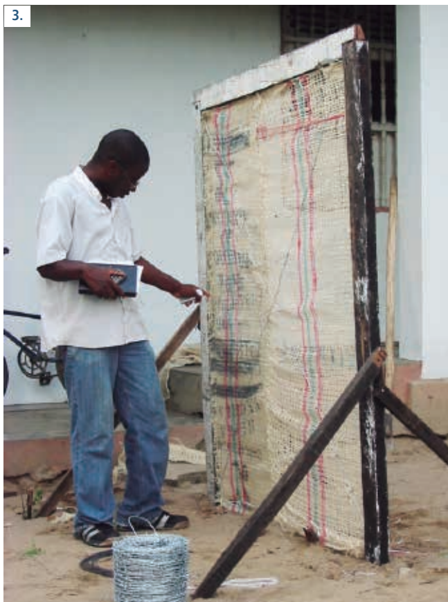
3. Para la fijación de la mezcla se puede emplear yute o costales de cabuya.
