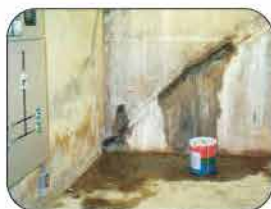
Etap 2 Reparación de Estructura con Radmyx
