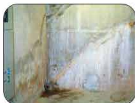
Etap 3 Reparación Exitosa con Radmyx
