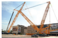
Esta nueva grúa tiene una capacidad de carga de 1,000 toneladas métricas y llega a más de 220 metros de altura.
