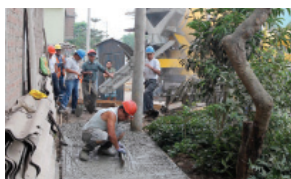
La empresa donó 198 m 2 de concreto premezclado, además del asesoramiento de sus profesionales.
