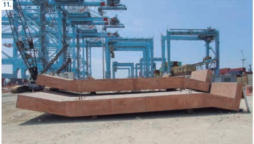
11. Se han elaborado más de 900 capiteles, 1,000 vigas y 2,000 losas para el proyecto. Las dos últimas tienen una medida de entre 4.50 m a 6 m, pero las losas de aproximación, que se apoyan entre el tablero del muelle y la costa y que permiten establecer una sola superficie de trabajo, poseen de 10 m a 12 m de longitud.
