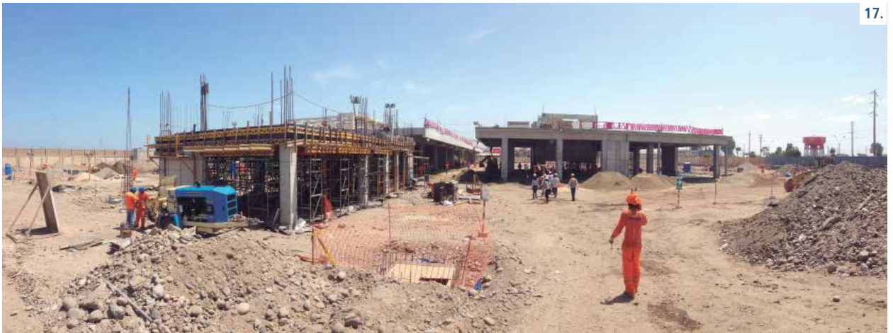
16 y 17. La obra fue ejecutada en concreto armado convencional, mediante columnas, vigas y losas macizas.
