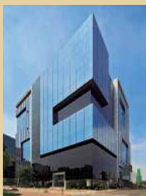
PACIFIC TOWER. Foto: Juan Solano.
