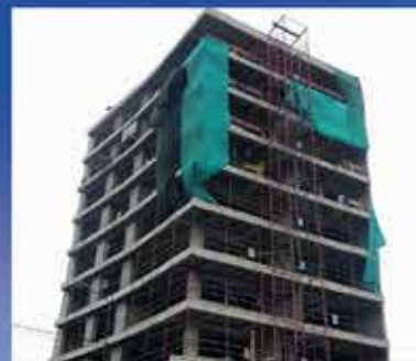
FASE DOS - EDIFICIO DE OFICINAS ROOSEVELT MIRAFLORES
