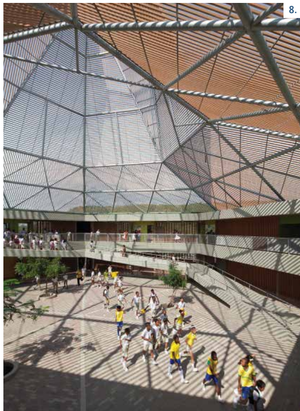
8 y 9. Los dos pisos de las aulas dan a un patio cubierto con cúpulas de madera que filtran el aire y la luz, permitiendo el crecimiento de los árboles. 10. La instalación se plantea como una construcción emblemática para el barrio donde se ubica. Su geometría y posición lo diferencian del contexto que lo rodea, y sitúa como un edificio de fácil reconocimiento que permite aglutinar a la comunidad.
