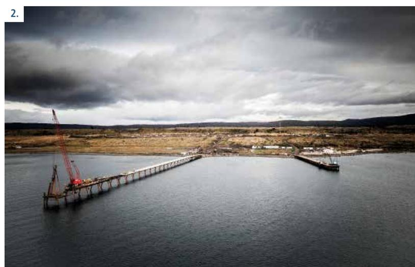
1. La operación minera utiliza el sistema de palas hidráulicas y camiones de alto tonelaje. 2. En la foto se aprecia el frente de trabajo con grúa avanzando desde tierra (a la izquierda) y el muelle de servicio usado para trasladar insumos a los frentes marítimos (a la derecha).
