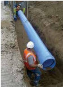
Las tuberías de PVC con orientación molecular tienen una alta resistencia hidrostática.
