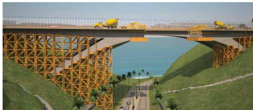
El puente tendrá 112 m de longitud y 11.7 m de ancho, 2 carriles de 3.5 m de ancho, una ciclovía de 1.80 m y una vereda de 2.5 m.
