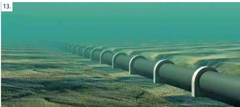
11, 12 y 13. El emisario submarino, que conducirá el agua tratada al mar, posee 3.5 km y se sumergirá hasta una profundidad de 60 m.
