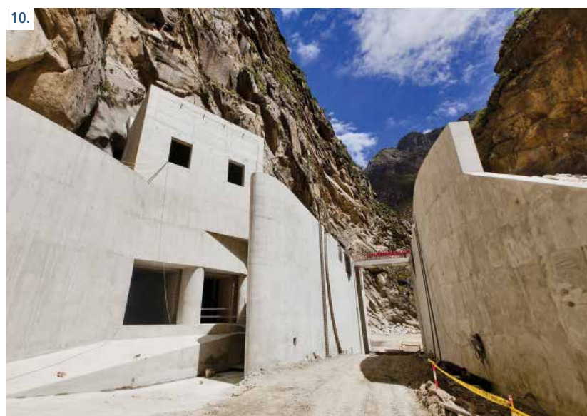
8. Otras de las tareas realizadas fue la derivación del río Quitaracsá. 9 y 10. Las obras principales se desarrollan, básicamente, en terrenos de vertiente montañosa y escarpados.
