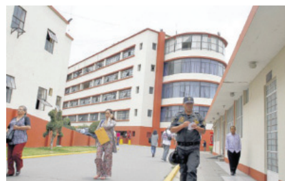
Actual hospital de la PNP no brinda buen servicio y está en malas condiciones.
