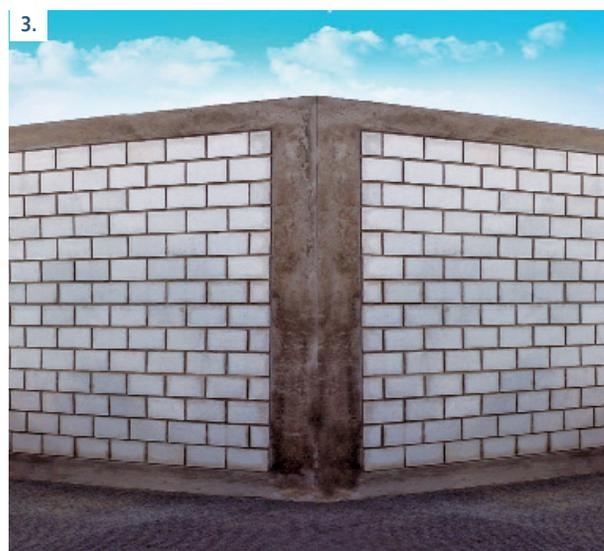
3. El ladrillo King Kong 11h está pensado especialmente para construir muros en albañilería confinada.
