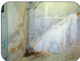
Etap 3 Reparación Exitosa con Radmyx
