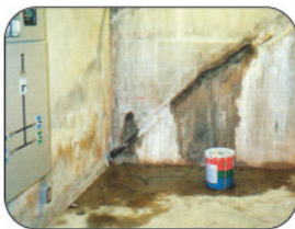
Etap 2 Reparación de Estructura con Radmyx
