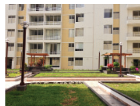
La obra se inició en mayo del 2012 y se encuentra ubicada en Surco.
