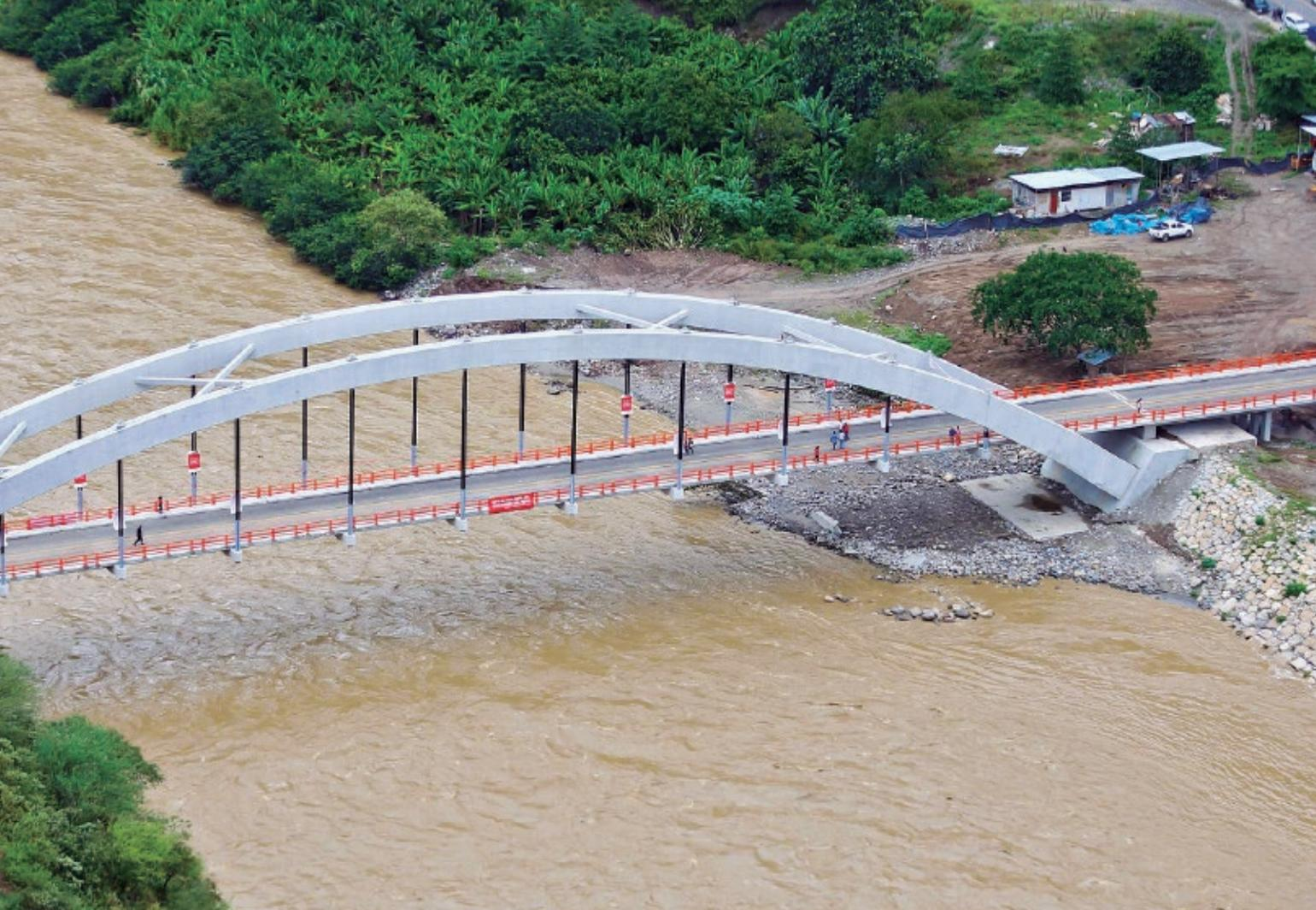
10.60 m, que proporciona un claro libre de 3.45 m sobre para el fondo de las vigas longitudinales del tablero, a 0.80 m debajo de la rasante. Las subestructuras están cimentadas a unos 3.40 m del fondo del cauce, debajo del nivel de socavación.
