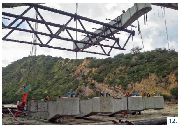
12, 13, 14 y 15. Las vigas transversales, de 9.80 m de longitud, fueron prefabricadas en obra e izadas y colgadas del arco mediante péndolas de acero a cada 10 m.
