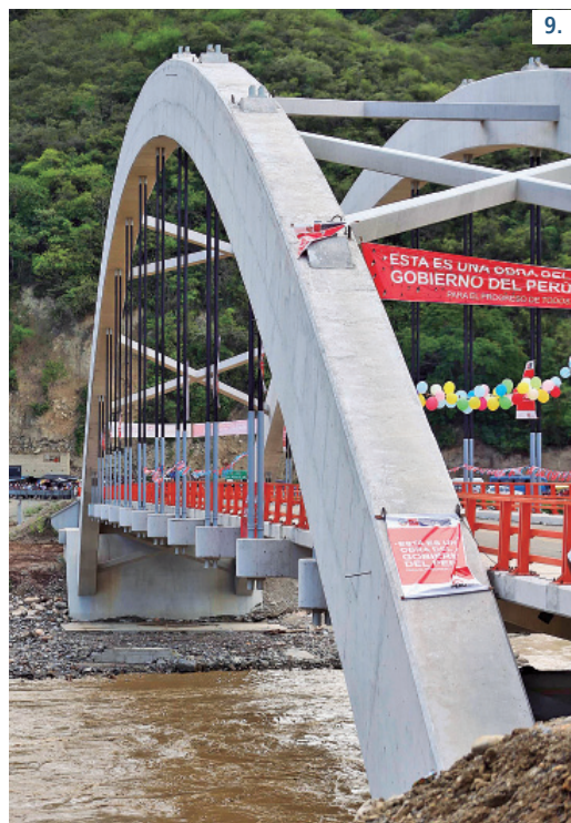
9. Los arcos tienen 130 m de luz entre arranques y 20 m de flecha. Cada uno tiene 1.20 m de ancho, espesor variable de 3.25 m en los arranques y 2.25 m en la clave.
