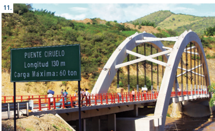
9. Los arcos tienen 130 m de luz entre arranques y 20 m de flecha. Cada uno tiene 1.20 m de ancho, espesor variable de 3.25 m en los arranques y 2.25 m en la clave.
