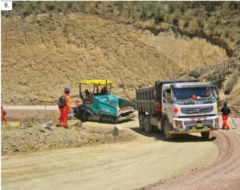
**9 y 10.** Las nuevas características de la carretera permitirán una velocidad directriz de 30 km por hora, en una carpeta asfáltica con espesor de 7.5 cm. El ancho de la calzada tendrá 6 m de longitud más 0.5 m de bermas a cada lado y un radio mínimo de 25 m de maniobra.
