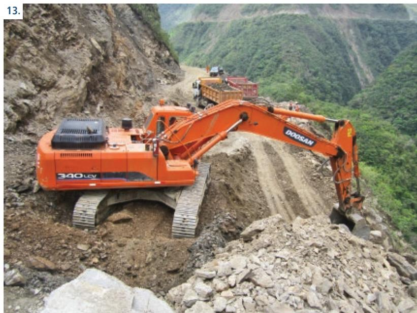
13. Para la etapa de movimiento de tierras se cuenta con 28 excavadoras, de las cuales 12 disponen de martillo hidráulico incorporado, que reemplaza el uso de explosivos, facilitando la remoción de roca suelta y fija.
