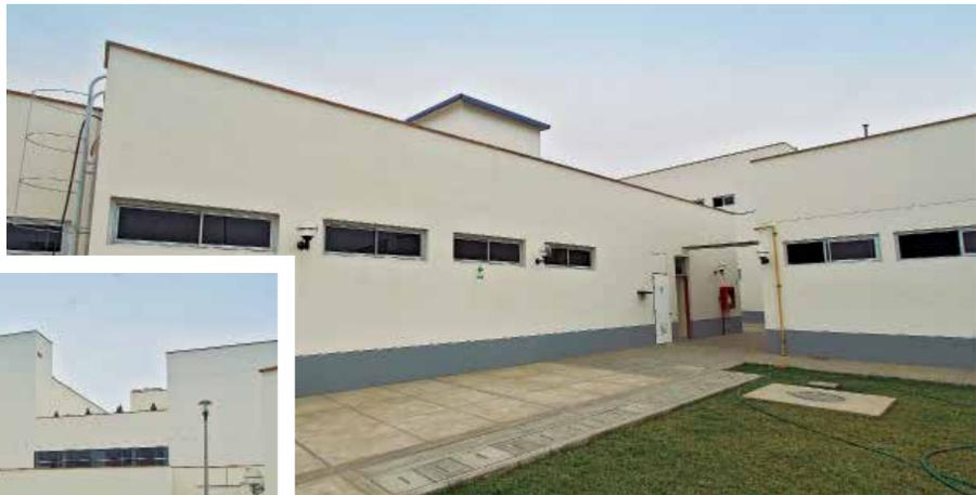
↖ *Los bloques de edificación han sido ubicados de tal forma que la orientación de la luz proveniente del este-oeste no dé en forma directa hacia las caras, sesgando la dirección de los ejes.*
