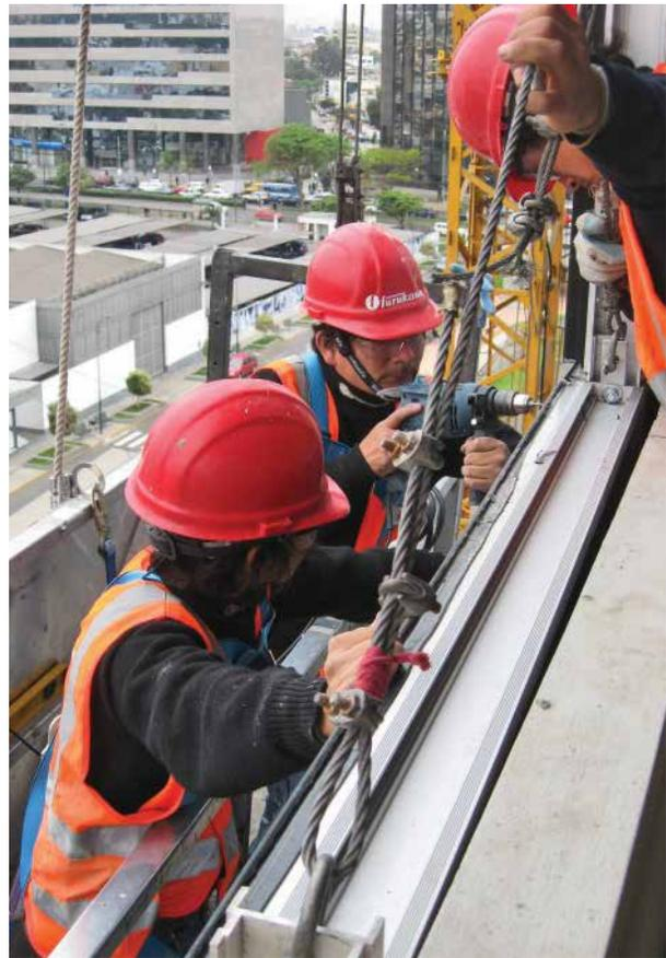
iniciar su instalación mientras se están vaciando las losas superiores; para el sistema stick se requiere tener todas las losas vaciadas para poder colocar la estructura base que recibirá los cristales”, expresó.
