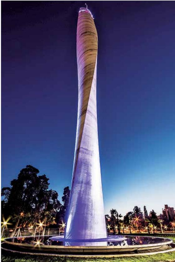
↙ *El Faro del Bicentenario es una columna de concreto de planta elíptica que asciende helicoidal, rotando sobre su eje hasta casi 90 m de altura, completando la pieza un mástil que alcanza los 102 m.*
