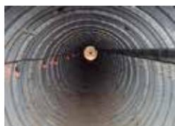
y redes de servicios públicos; no produce asentamiento de las calzadas o las vías, y las planchas de acero galvanizado poseen excelente durabilidad en ambientes agresivos, además de bajos niveles de manutención. ■
