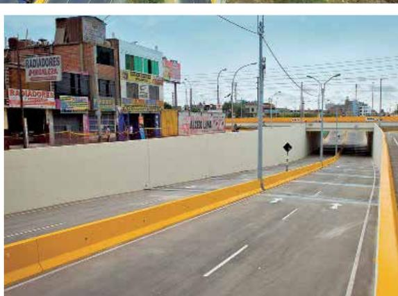
La ejecución del paso a desnivel Los Alisos supone la depresión de la rasante de la avenida del mismo nombre en aproximadamente 340 m mediante la realización de zajón en el terreno.
