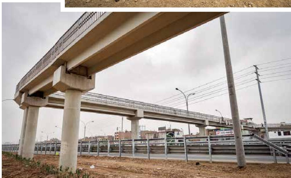
La obra se complementa con la construcción de dos puentes peatonales compuestos de 4 vanos: 2 de 15m de luz en pista y 2 de 14 m en los laterales.
