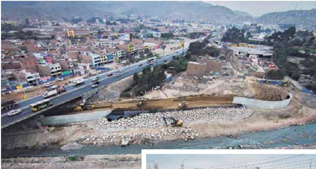
En los Óvalos de retorno Chillón la actividad más resaltante es la defensa de las riveras. Se ejecutaron muros de concreto, enrocados de protección, impermeabilización, drenajes, etc.
