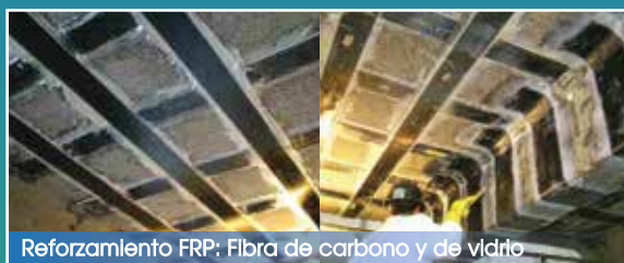
Rehabilitación y Reforzamiento Estructural
