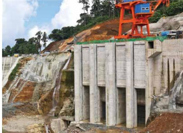
El embalse compensador está conformado por una presa de encochado con una pantalla de concreto de 58 m de altura, vertedero de excesos, y estructura de toma para las tuberías de presión.
