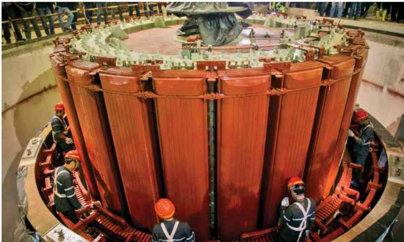
◀ Descenso del rotor en la casa de máquinas.
