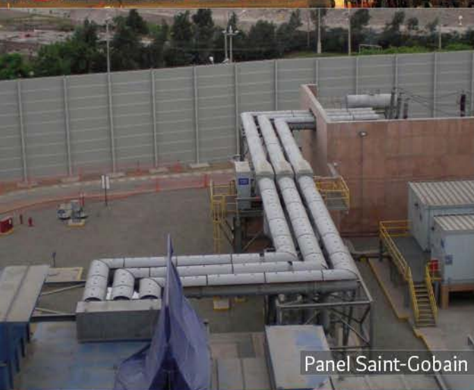
Andamios - Proyecto OHL Industrial - PLUS PETROL
