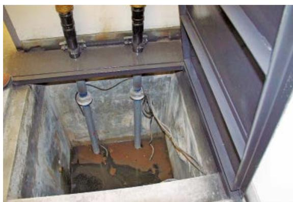
También se instaló un sistema de bombeo con dos electrobombas sumergibles, las cuales trabajan alternadamente según la demanda, siendo capaces de bombear sólidos de hasta 20 mm.
