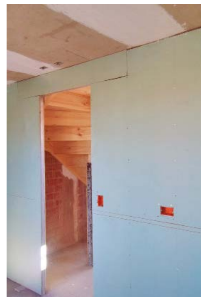
La instalación de las planchas de yeso es mucho más rápida que la tabiquería tradicional de ladrillo.
