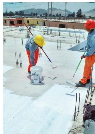
➤ Paso 2: Después de 6 horas, se aplica una segunda y última capa de producto Z 2000 usando rodillo.
