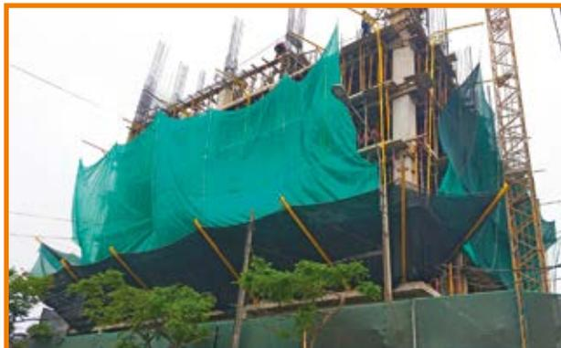
**Omegas:** Elemento donde se apoyan las horcas. Hechas de varilla de acero corrugado o liso de diámetro  $\geq \frac{1}{2}$ ". Se anclan en el borde de losa de techo o la placa de concreto.
