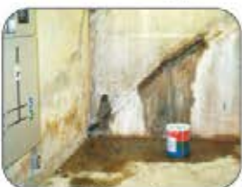
Etapa 2 Reparación de Estructura con Radmyx
