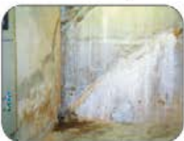
Etapa 3 Reparación Exitosa con Radmyx
